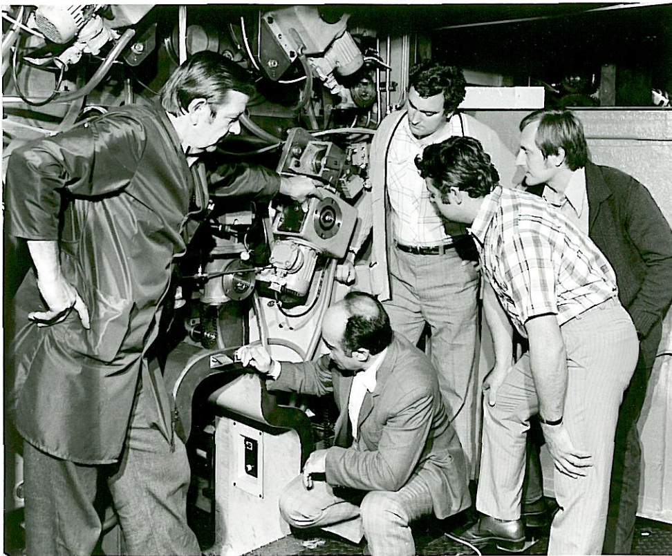
Schulung ungarischer Monteure an Rondoset-Anlagen
