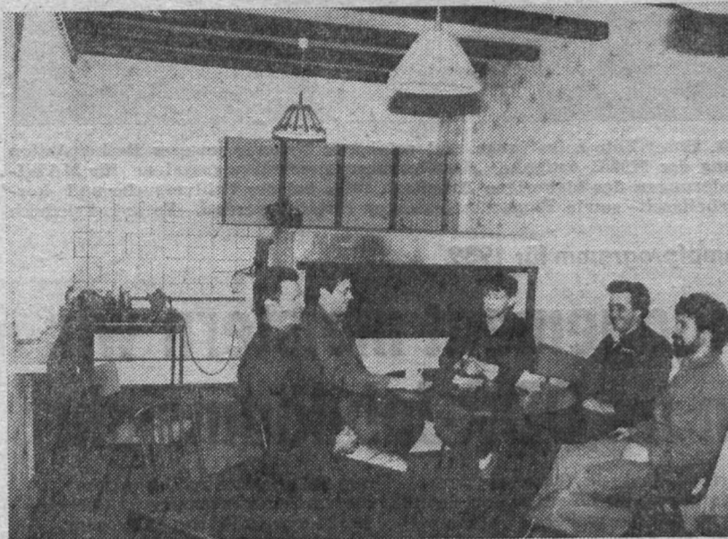
Bei der Umgestaltung des Anbaues am Objekt 012 konnten sich die Kollegen der Rohrleitungsinstandhaltung eine neue Garage für den E-Karren und einen niveauebenen Pausenraum schaffen (Bild). Diese Maßnahme ermöglichte mehr Platz in der Werkstatt wodurch sich die Arbeits- und Lebensbedingungen wesentlich verbessert haben. Foto: D. Heinrich
