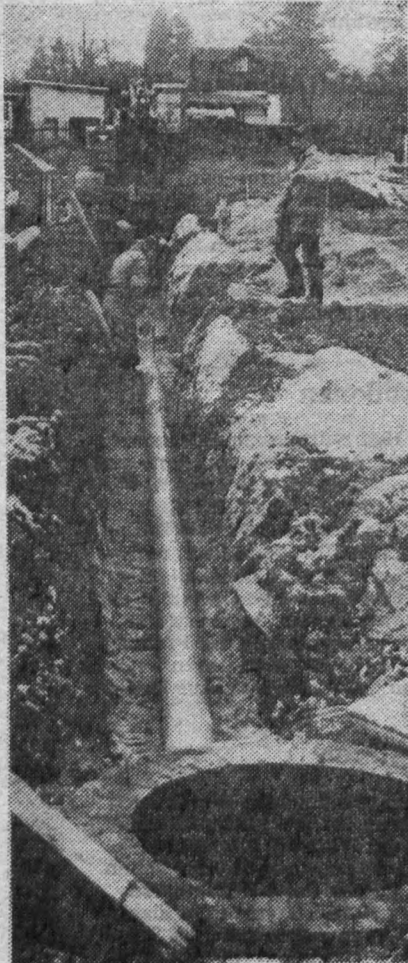
Rohre für die Kanalisation werden verlegt.
