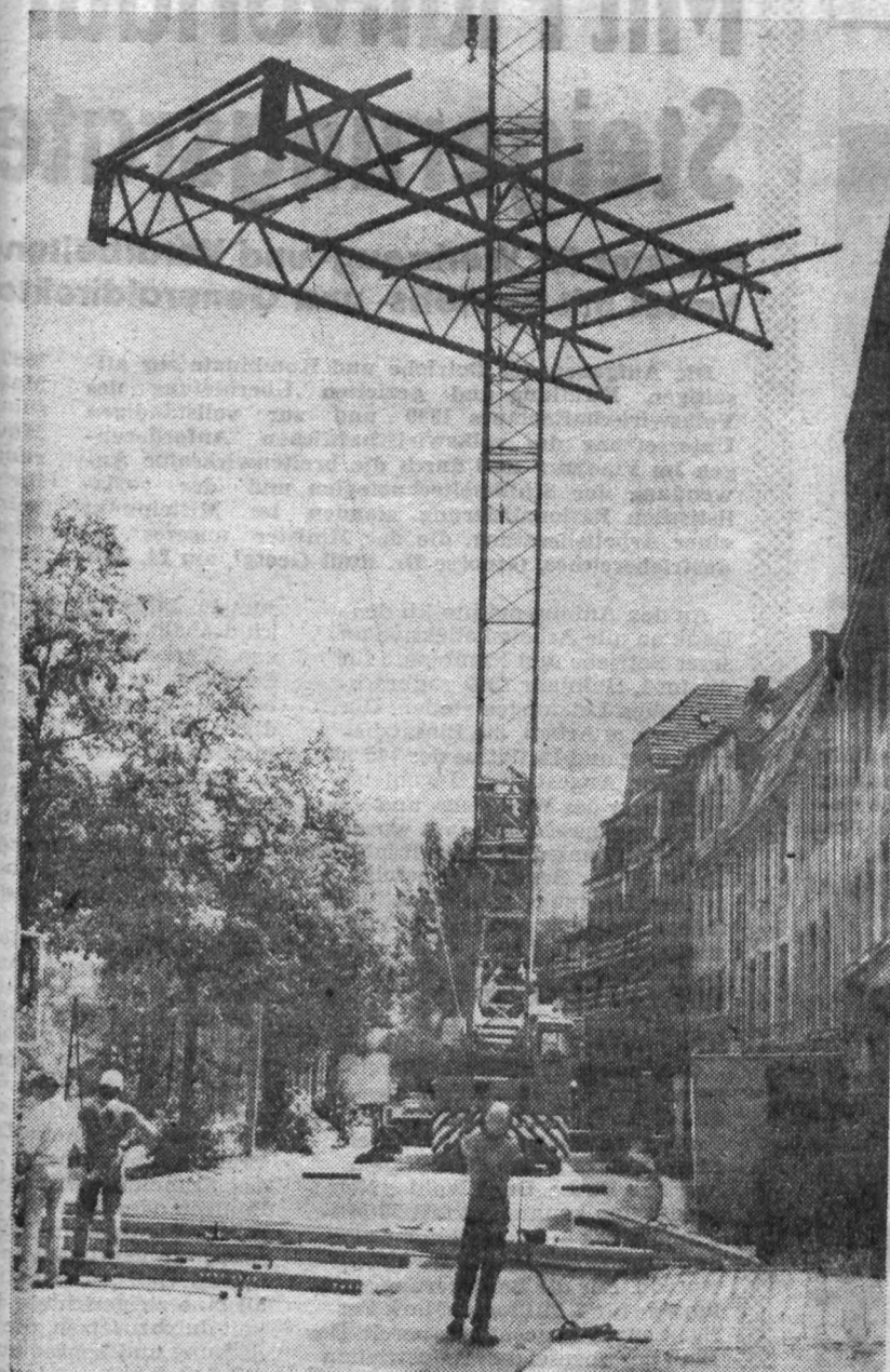
Ein Montagekran beherrschte das Bild auf der Hans-Sachs-Straße. Diese Technik ist für die Rekonstruktion des Formereihallendaches unentbehrlich. Nach einer Havarie konnten die Montagearbeiten am 4. August wieder aufgenommen werden.
