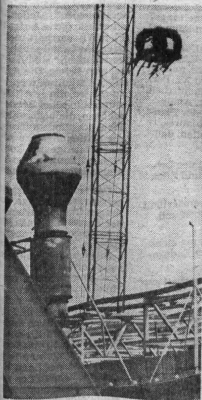
Am 14. August war es soweit: Mit dem Kran wurde die Richtkrone auf das Hallendach gesetzt.
