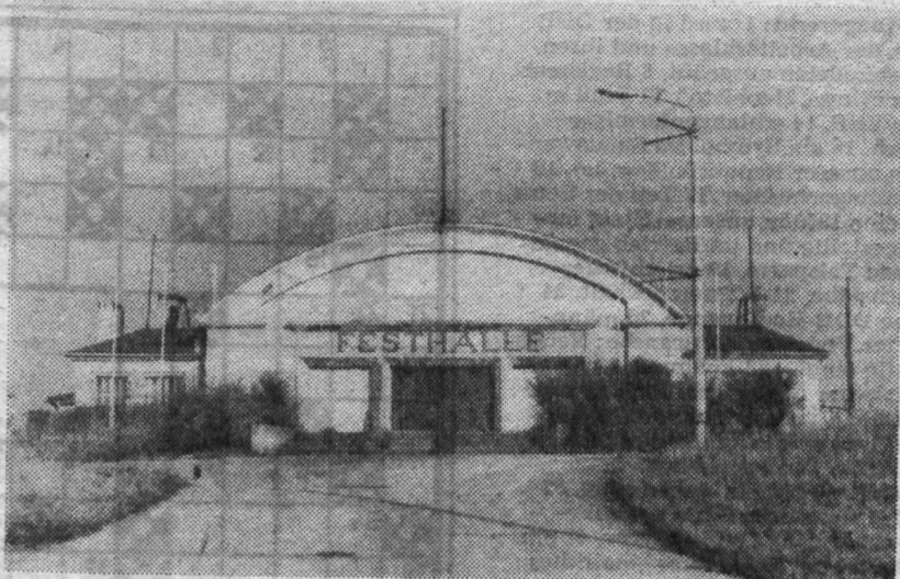
Die alte Festhalle wenige Wochen vor dem Abriss.
