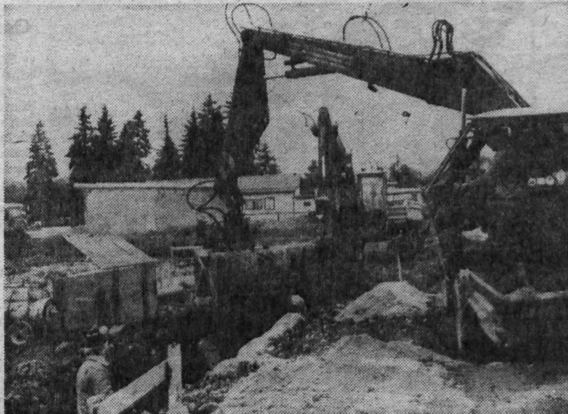
Bautechnik beim Ausheben von Gräben.
