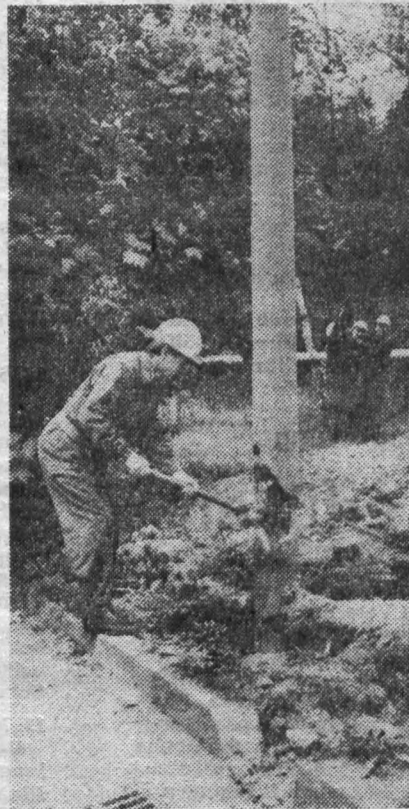
Baustelle Objekt 2. Notstromdiesel. BI-Kräfte des Zuges Horlbeck entfernen einen Lichtmast und montieren danach eine NA-Leuchte an das Gebäude.
