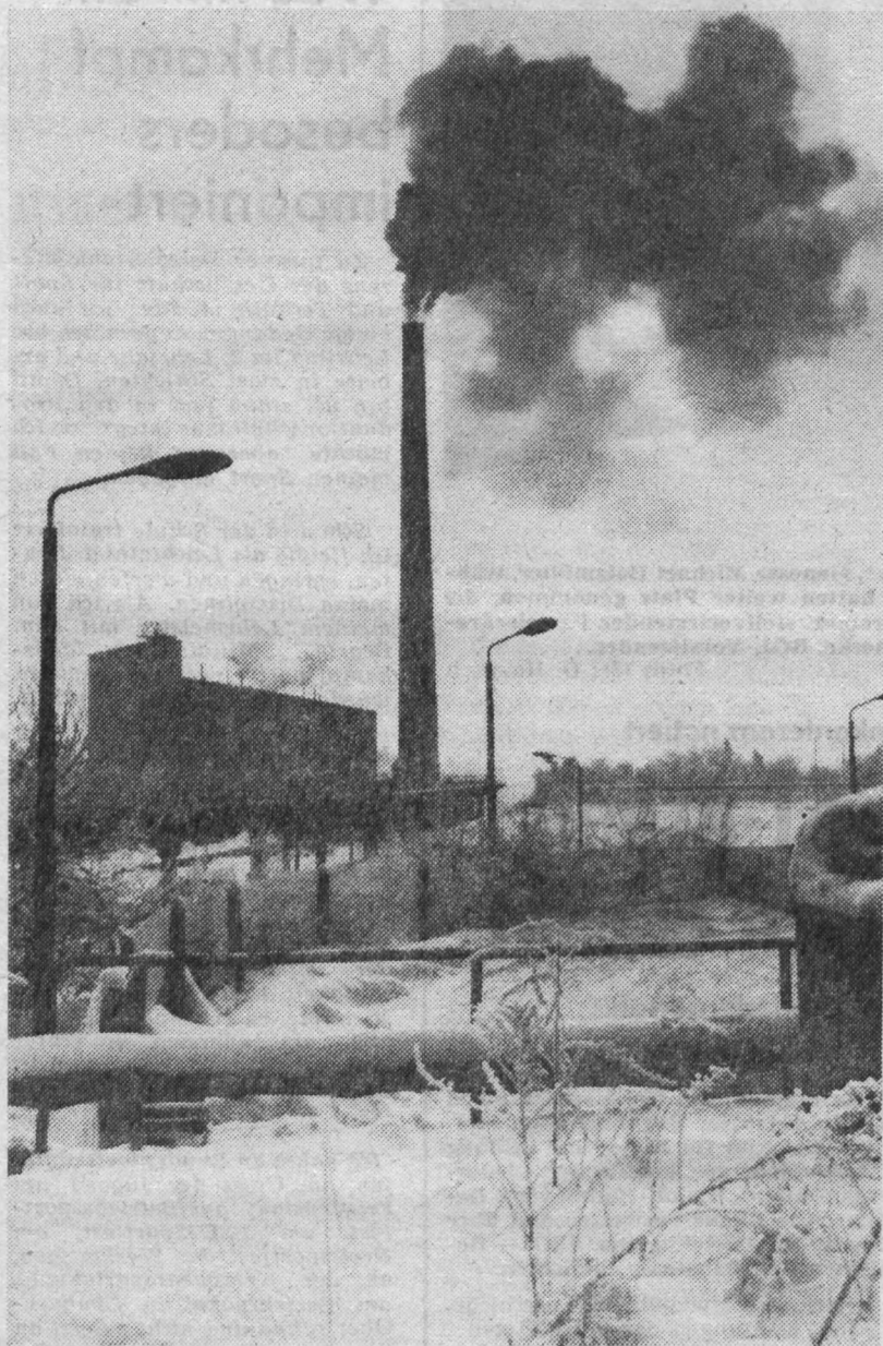
Blick auf das Heizkraftwerk unseres Betriebes. Täglich wurden während der extremen Winterbedingungen im Januar nahezu 400 Tonnen Rohbraunkohle für die Dampferzeugung benötigt. Das bedeutete für das Kollektiv des Heizwerkes und ihre Helfer harte, angestrengte Arbeit.
