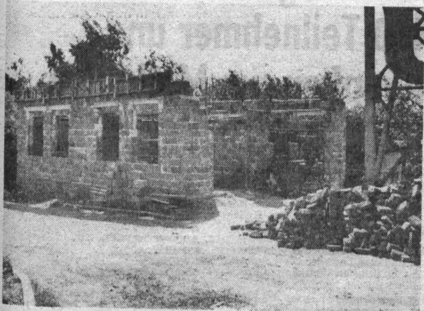
Neben der Dampfumformerstation entsteht ein neues Gebäude für ein zweites Notstrom-Dieselaggregat. Fotos (2): D. Heinrich
