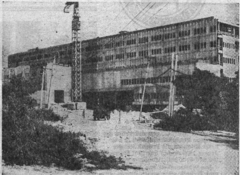
Das neu entstehende Druckkombinat in Havanna. Die Maschinen konnten dort wie auch in Holguin durch unser Montagekollektiv technisch übergeben werden.
