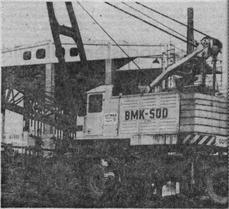
Mit dem Bau einer neuen Modelltischlerei wurden wesentliche Voraussetzungen für ein höheres Produktionsniveau, aber auch für bessere Arbeitsbedingungen der Werkstätten geschaffen. Unser Foto entstand bei der Montage der Betonfertigteile im Jahre 1968.
