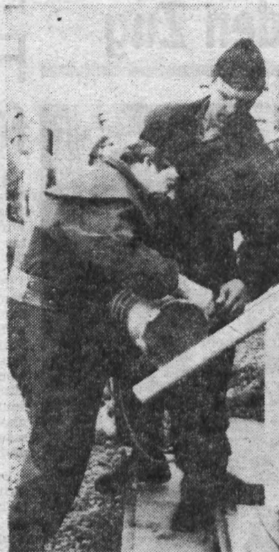
Kameraden der betrieblichen FFw gemeinsam mit Angehörigen der Entgiftungskräfte bei Vorbereitungsarbeiten für das Auspumpen eines wiederentdeckten Brunnens. Im Vordergrund die Kameraden Bernd Gleißberg und Herbert Haufe von der FFw. Insgesamt wurde von allen Einsatzkräften während der Übung ein ökonomischer Nutzen von 23 000 Mark geschaffen.
