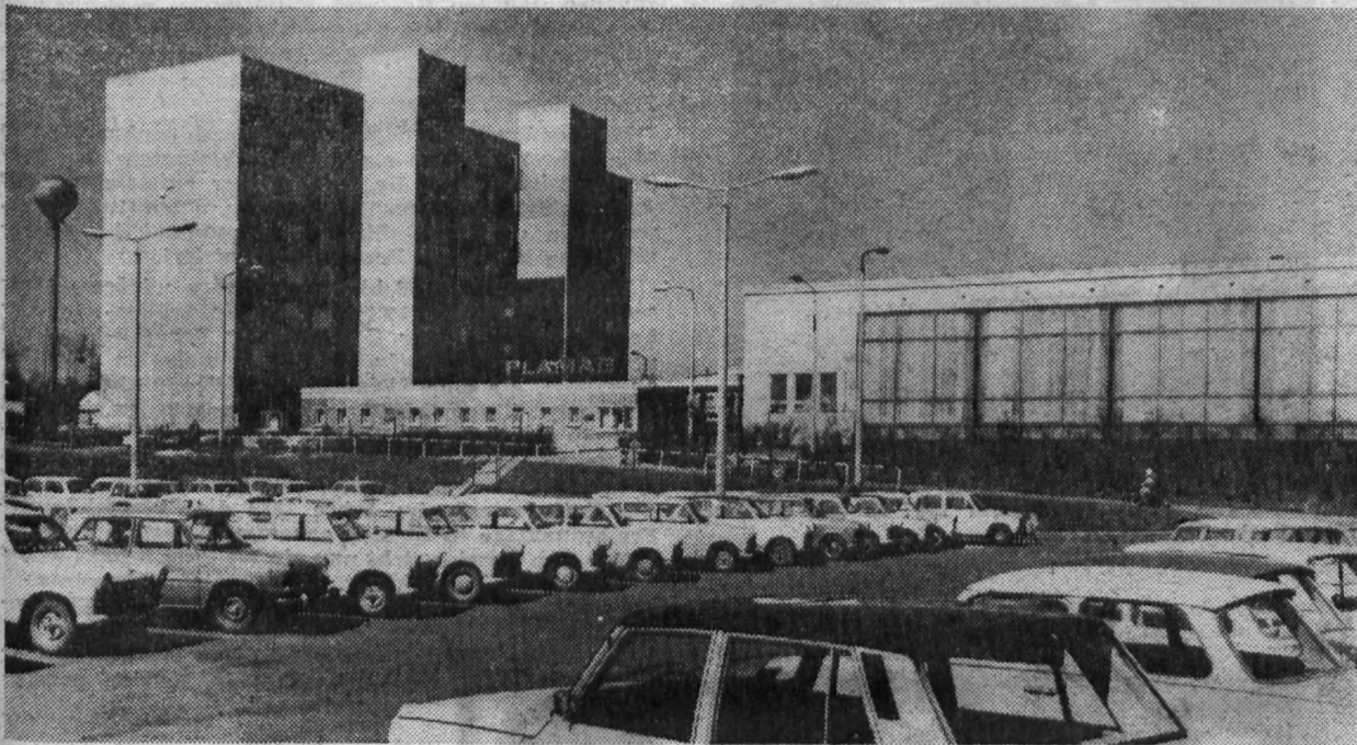
Unser Betrieb im 40. Jahr seines Bestehens. Das Verwaltungshochhaus einschließlich Eingangszone und Küche mit Speisesaal entstand während der umfangreichen Rekonstruktion unseres Betriebes in den Jahren 1968 bis 1972.
