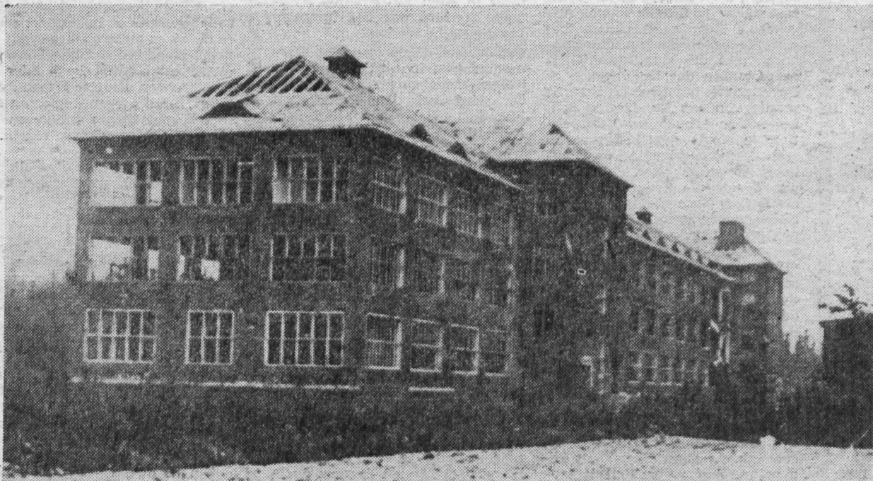
Dieses bombenbeschädigte Gebäude und zerstörte Werkstätten des ehemaligen Rüstungsbetriebes Horn auf unserem heutigen Betriebsgelände waren die traurige Hinterlassenschaft des faschistischen Regimes in Deutschland und der Grundstein für den weiteren Ausbau unseres Werkes, nachdem die Werkhallen an der Leuchtmühle nicht mehr ausreichten.
