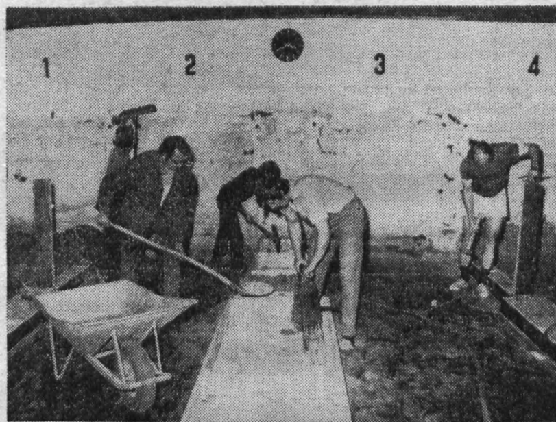
Vielseitige Arbeiten sind im Zusammenhang mit dem Einbau der automatischen Kegelaufstellung in unserer Kegelsportstätte zu leisten.
