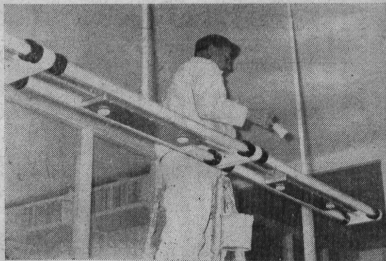
Emsig gearbeitet wurde noch in den ersten Januartagen. Maler, Elektriker, Klempner, Schlosser und andere Handwerker legten noch letzte Hand an, um unserer Belegschaft das neue Sozialgebäude mit dem 20. Januar völlig eingerichtet übergeben zu können.
