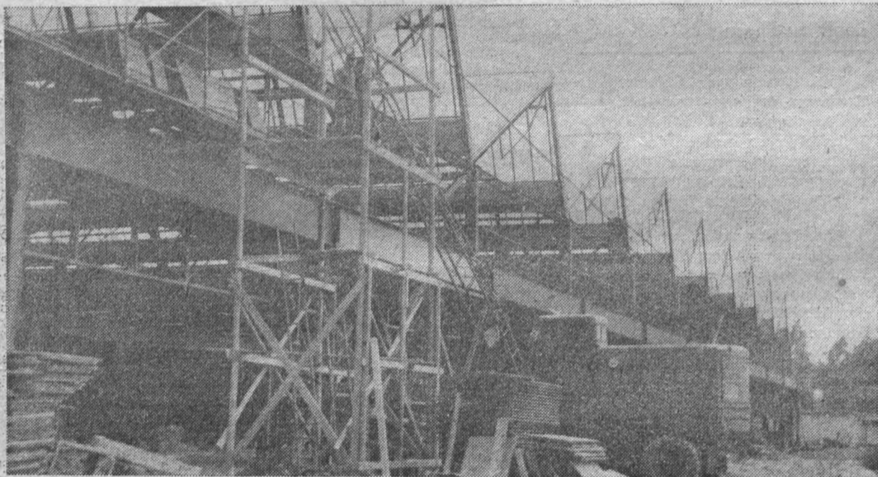
Sechs neue Produktionshallen entstehen längs der Pausaer Straße, so daß sich der Betrieb allein in dieser
